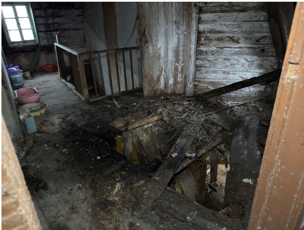
Fot.39-poddasze – korytarz – uszkodzenia podłogi
