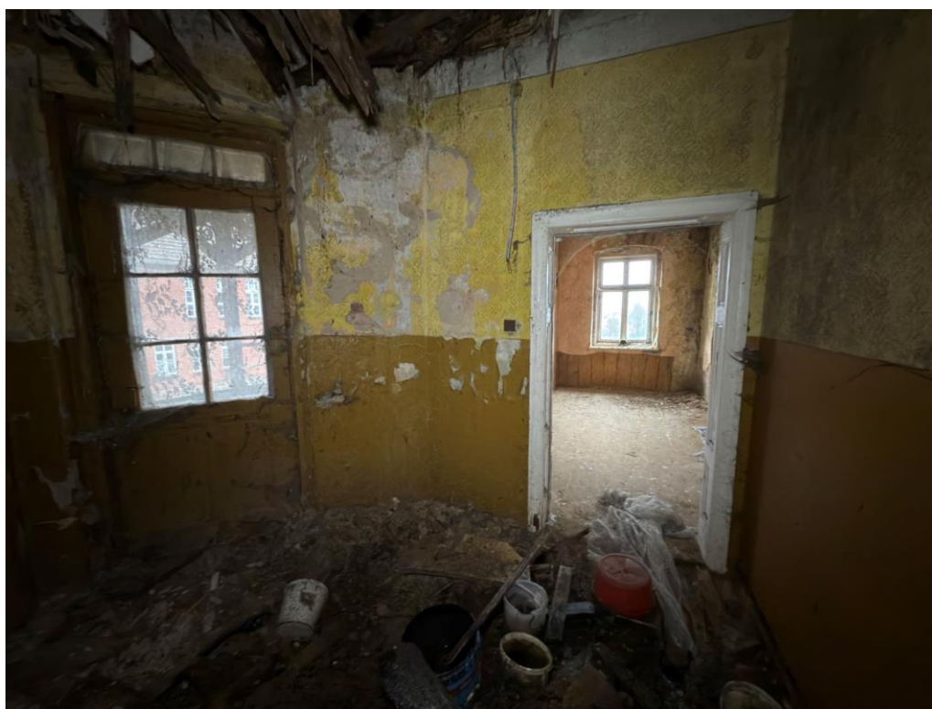
Fot.30-I piętro – korytarz, uszkodzenie stropu
