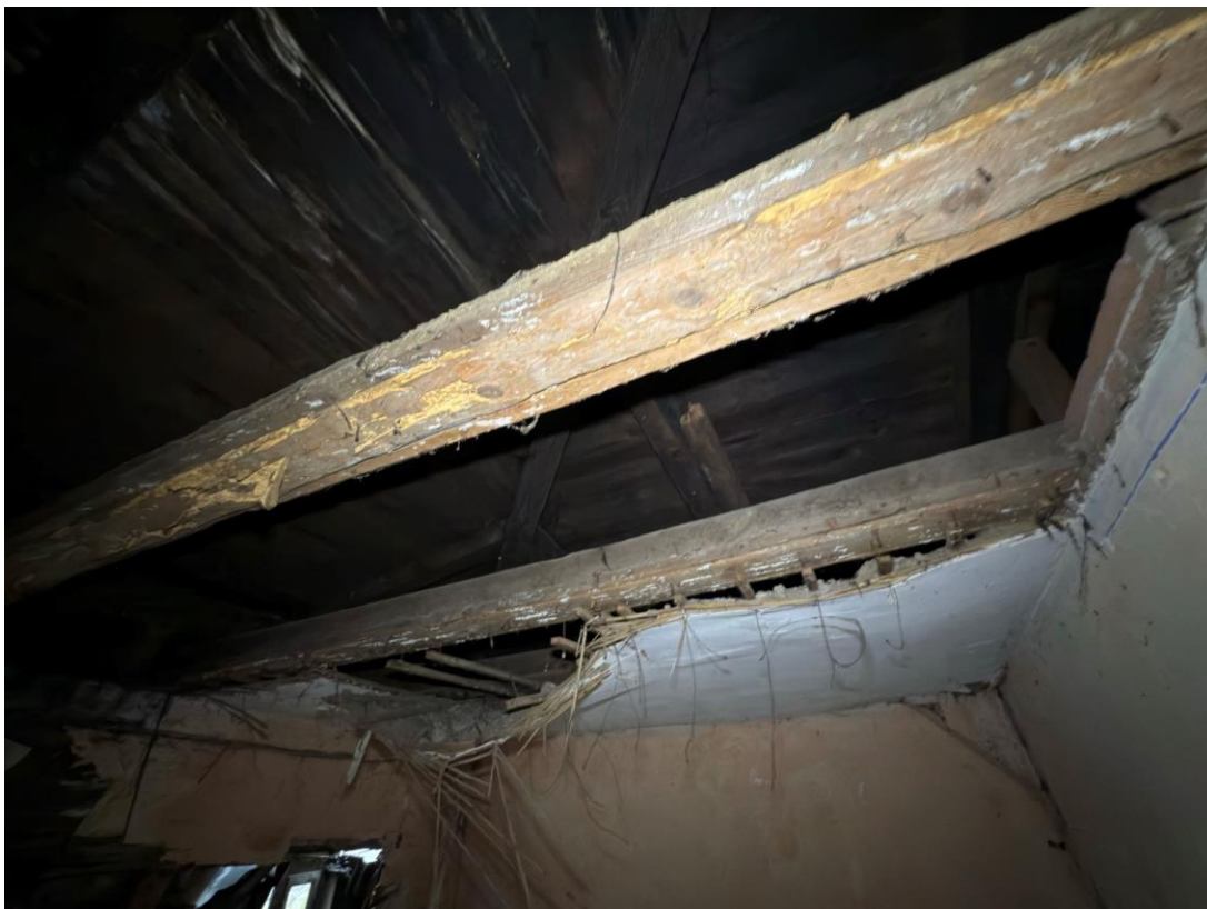
Fot.45-poddasze – pokój, uszkodzenia stropu
