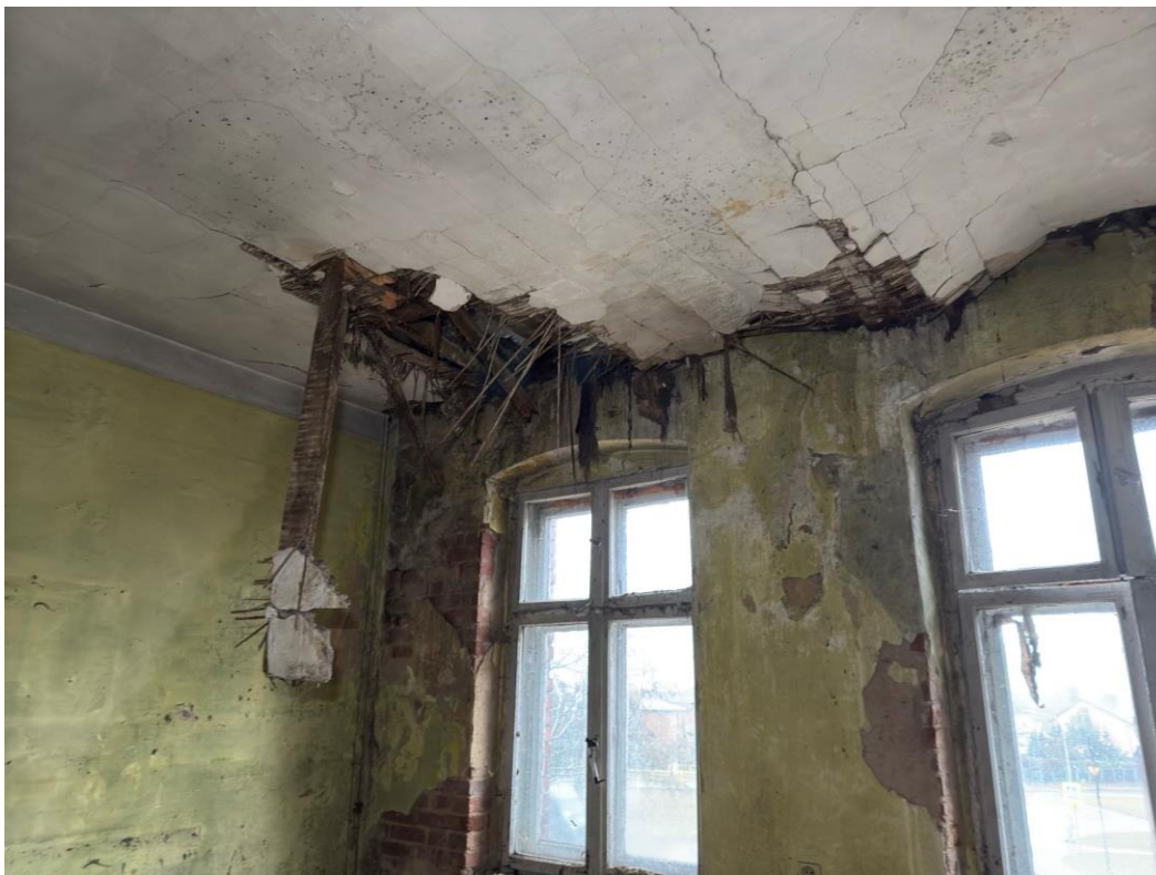
Fot.33-I piętro – pokój, uszkodzenia stropu
