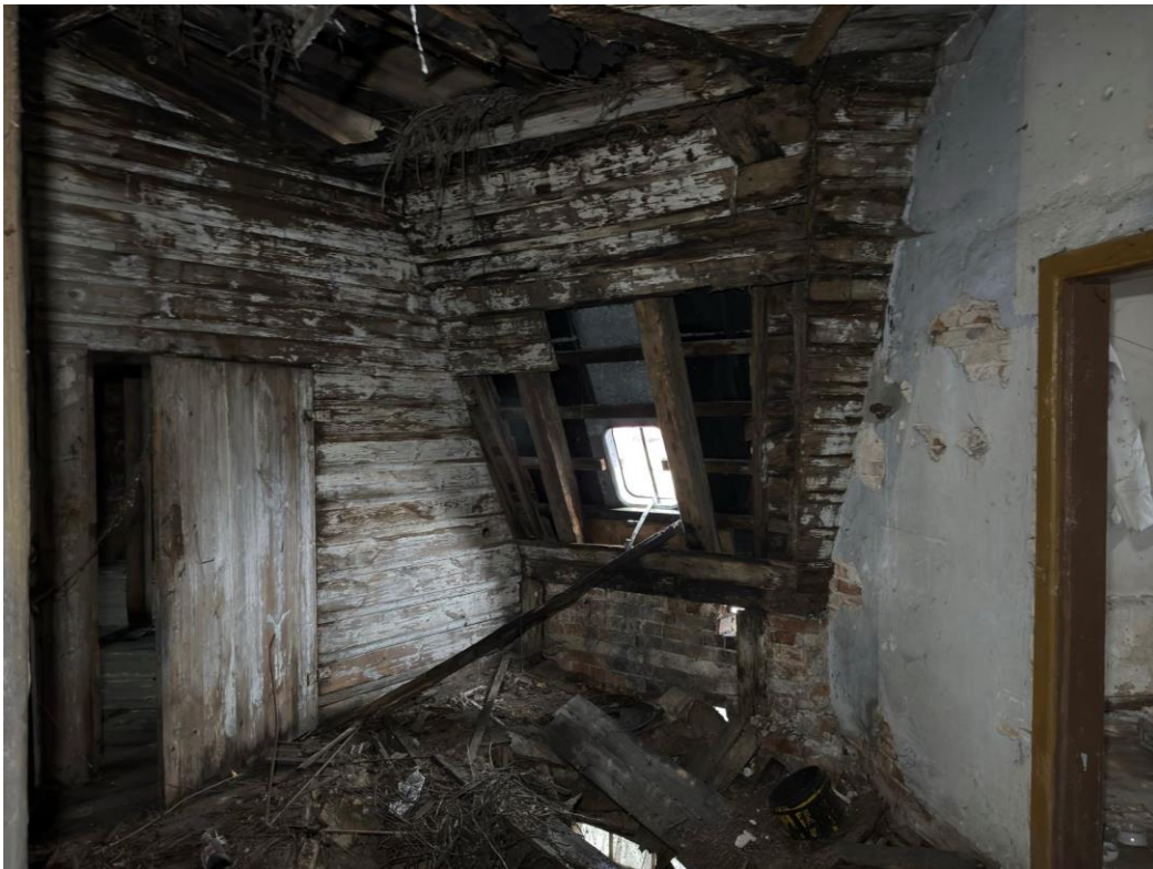
Fot.38-poddasze – korytarz – widoczne uszkodzenia podłogi i dachu, korozja biologiczna elementów drewnianych
