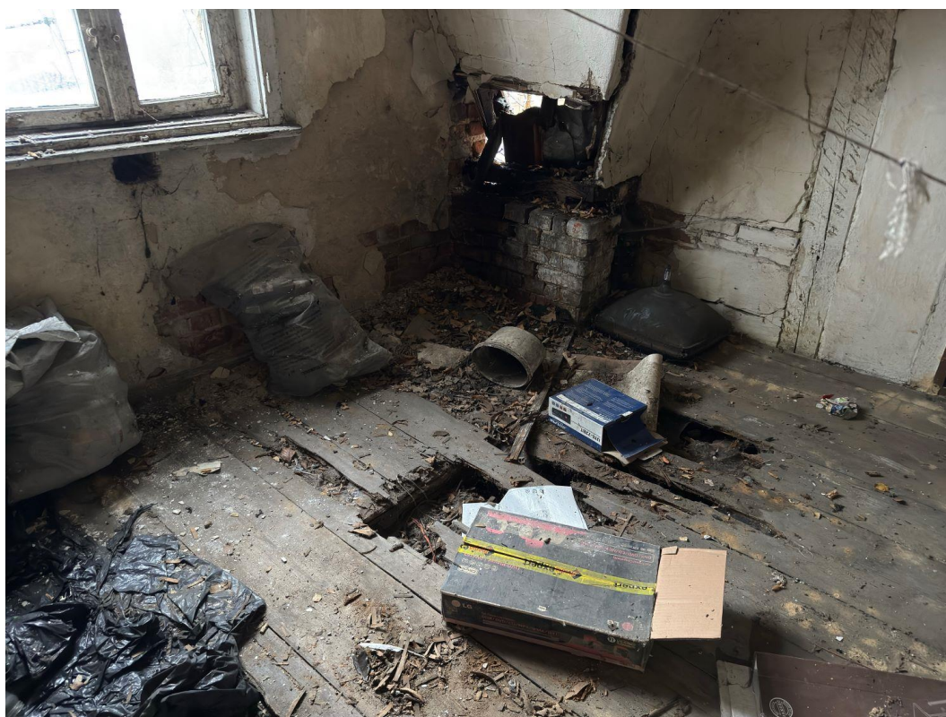
Fot.46-poddasze – pokój, uszkodzenia podłogi i ścian
