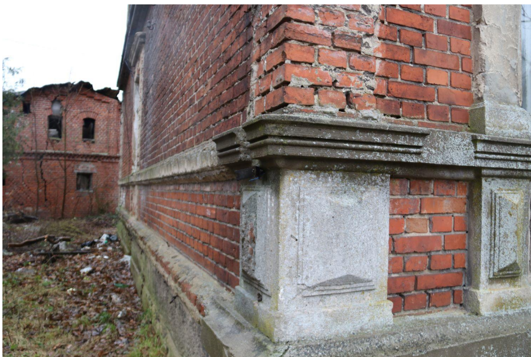
Fot.12-elewacja wschodnia – widoczne ubytki spoin w murze
