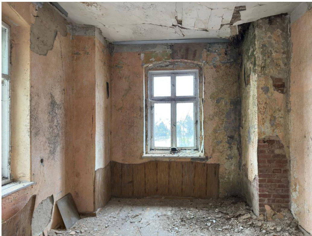
Fot.31-I piętro – widoczne uszkodzenia stropu, braki i korozja tynków
