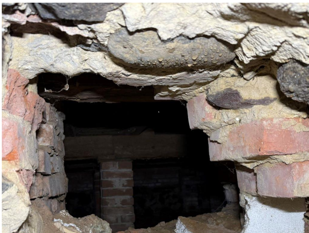
Fot.18-piwnica – widoczne skropliny wody
