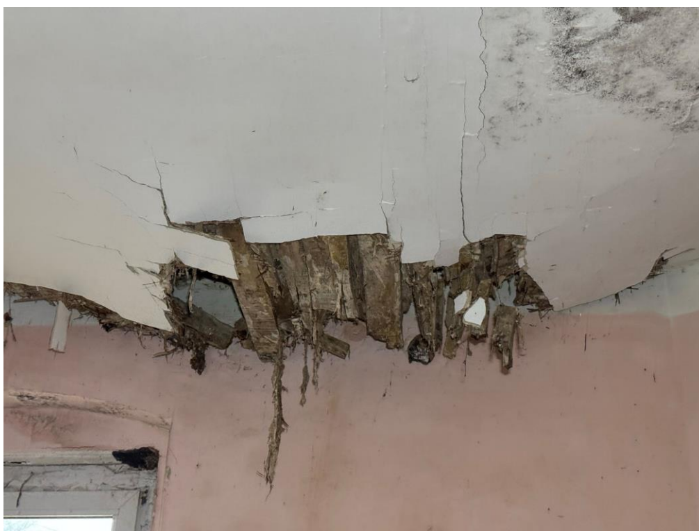
Fot.28-parter – uszkodzenie stropu
