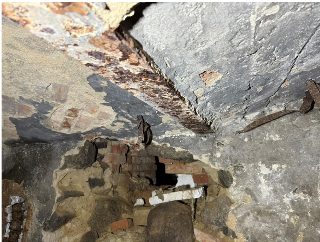
Fot.17-piwnica – korytarz, widoczna korozja belki stropowej
