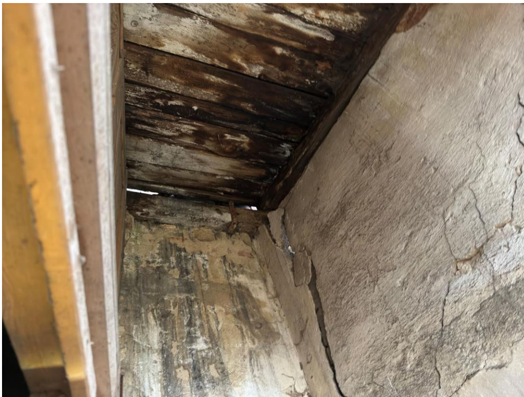
Fot.35-I piętro – przybudówka – uszkodzenia ścian, korozja biologiczna elementów drewnianych
