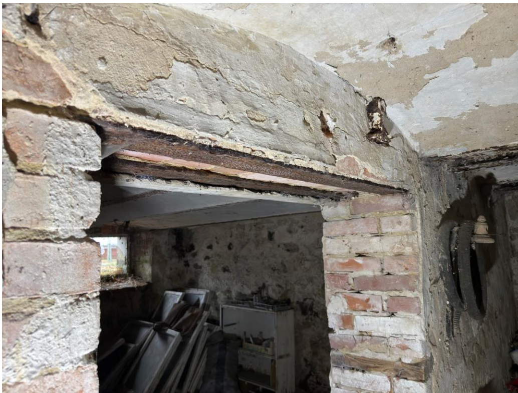
Fot.21-piwnica – widoczna korozja nadproża stalowego
