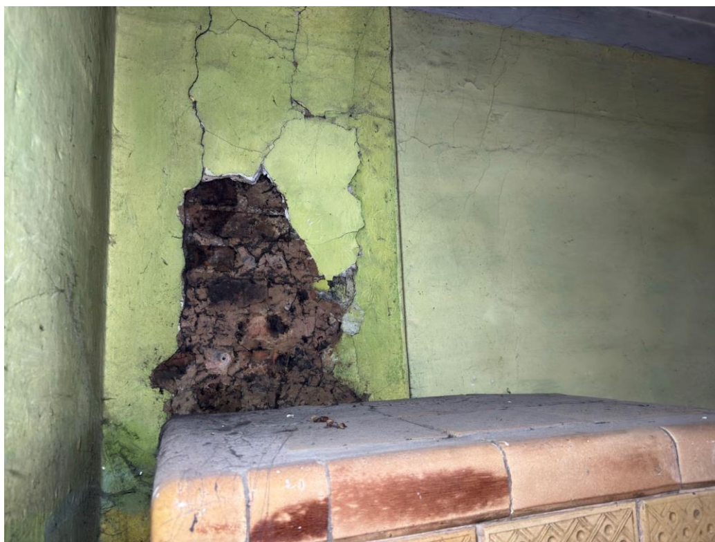
Fot.34-I piętro – komin, korozja chemiczna tynków i ścian
