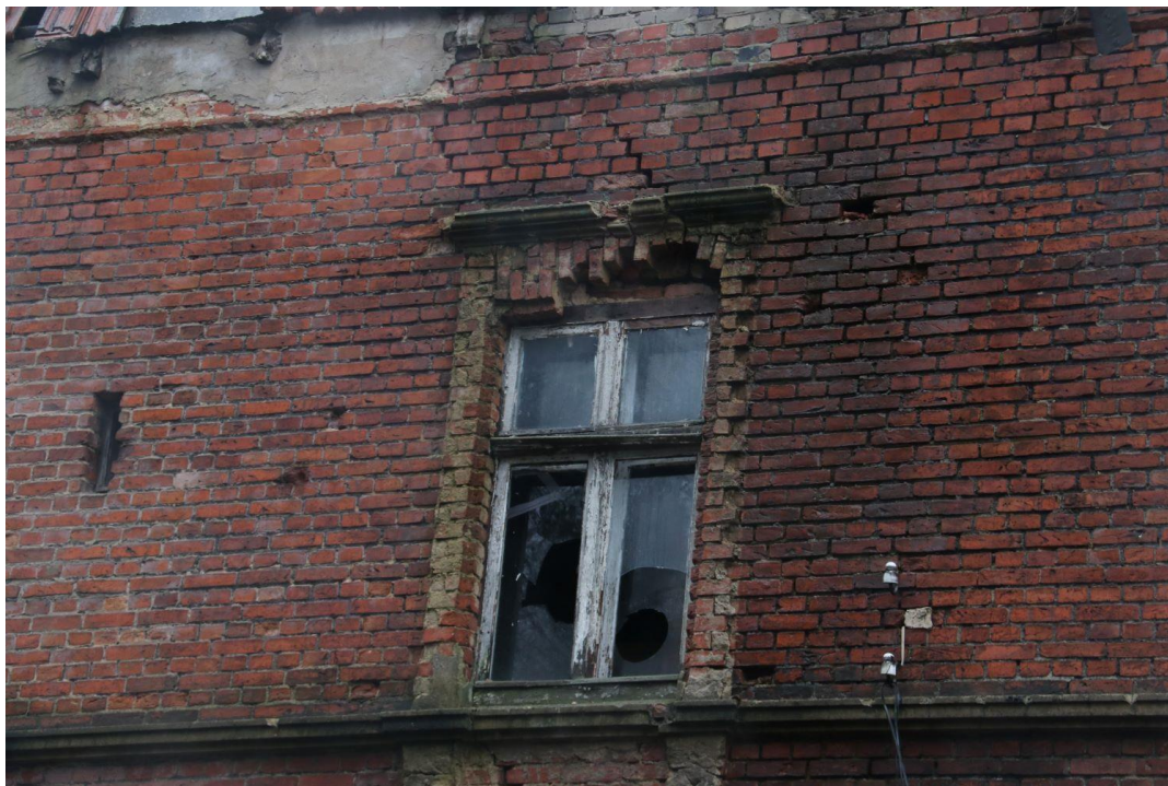
Fot.7-elewacja południowa – ubytki cegieł w nadprożu, pęknięcie muru nad nadprożem, ubytki cegieł i spoin w ścianie murowanej
