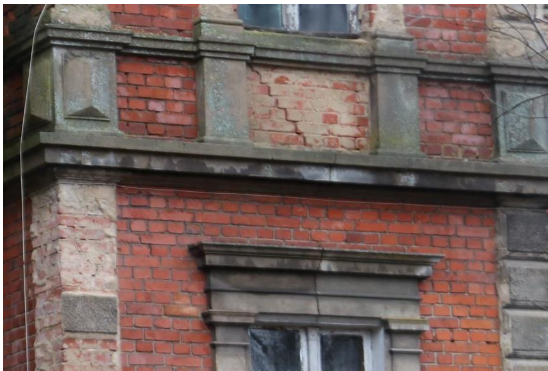
Fot.10-elewacja wschodnia – widoczne pęknięcie muru
