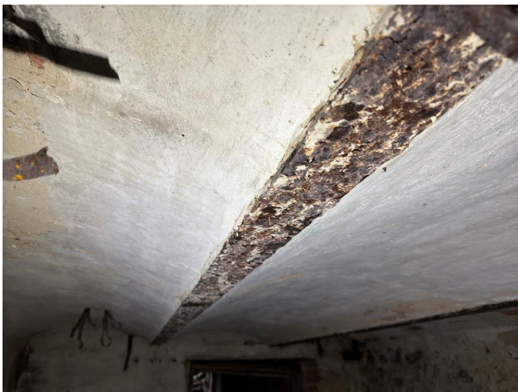
Fot.20-piwnica – widoczna korozja stalowej belki stropowej
