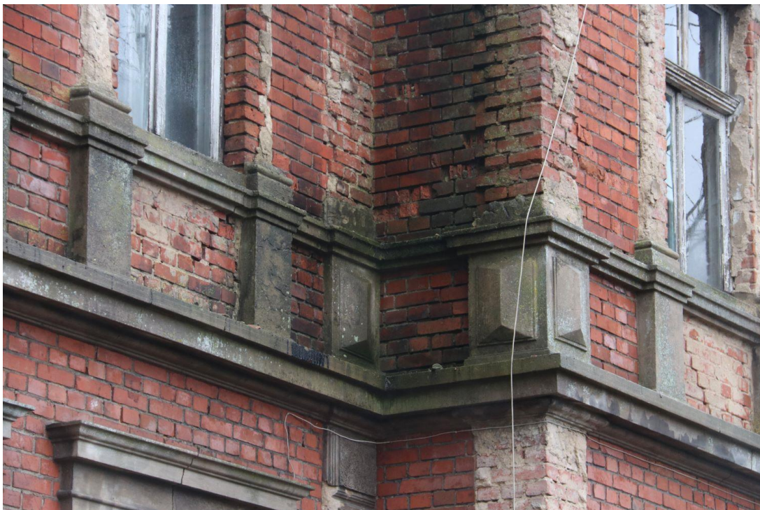
Fot.11-elewacja wschodnia – widoczne ubytki cegieł w murze
