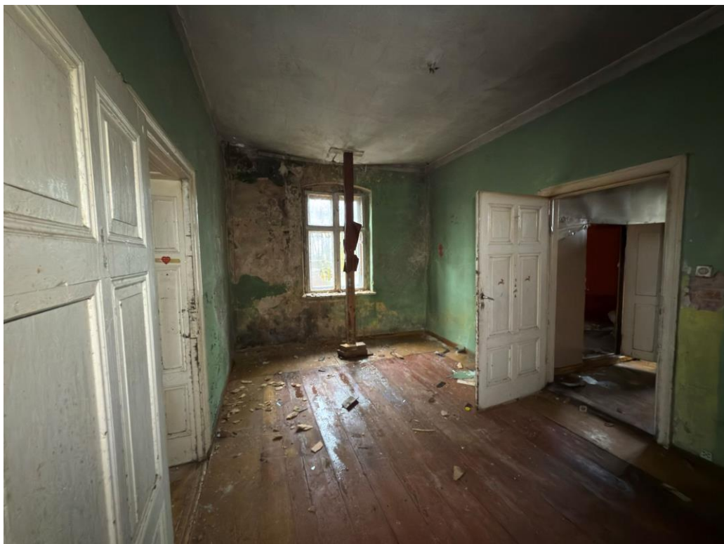
Fot.32-I piętro – pokój, nadmierne ugięcia stropu, strop dodatkowo podparty słupem drewnianym
