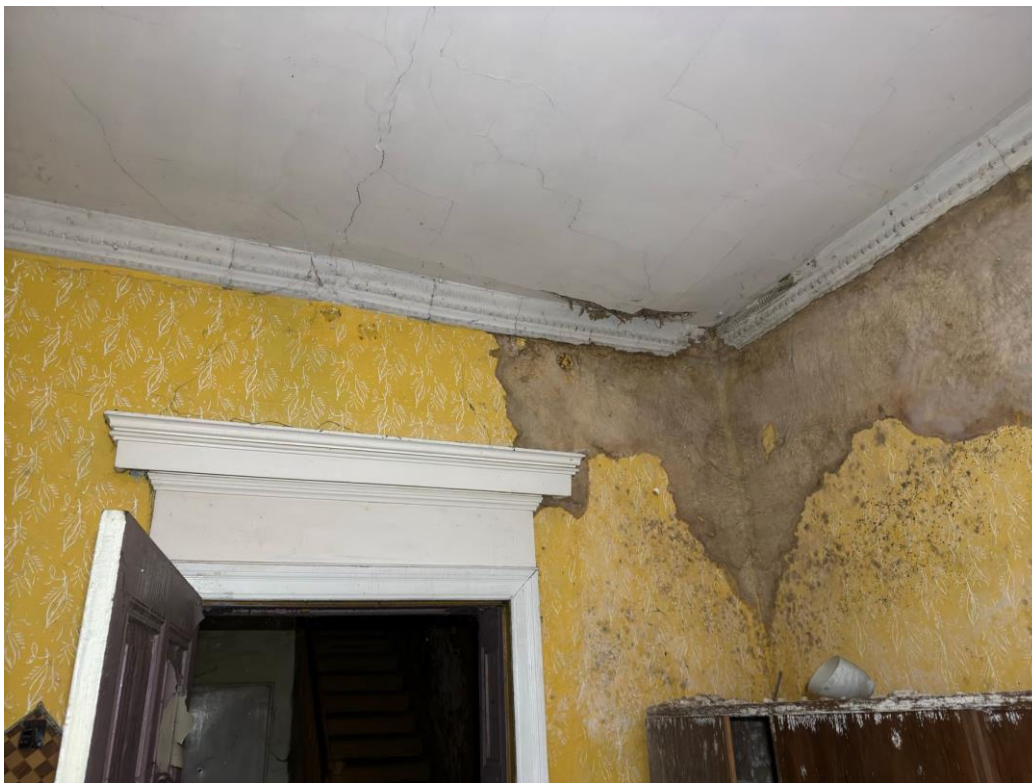
Fot.25-parter – pokój, uszkodzenia ścian z powodu zawilgocenia
